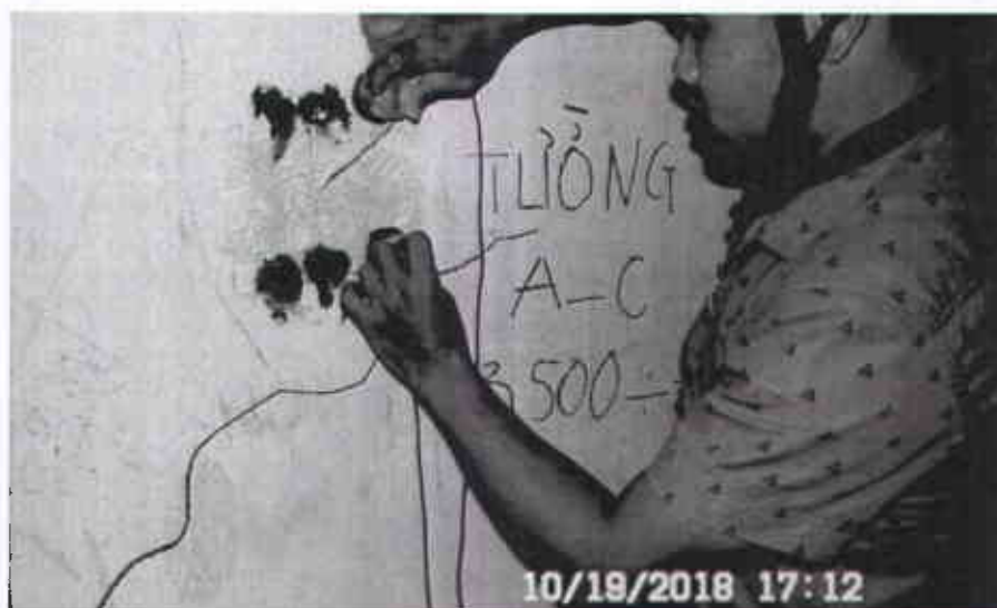
Hình 4.21 - Công tác kiểm tra cường độ bê tông tường dùng thiết bị siêu âm
