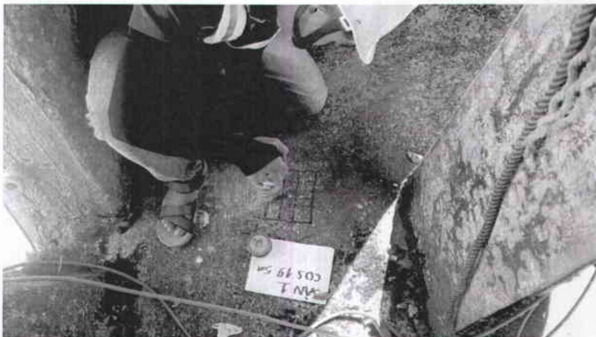
Hình 4.17 - Công tác kiểm tra cường độ bê tông sàn dùng thiết bị bật nảy
