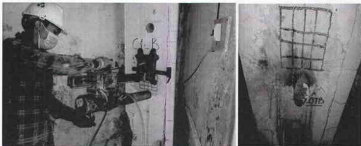
Hình 4.23 - Khoan mẫu cột tại hiện trường
