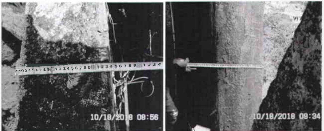
Hình 4.5 - Xác định bề rộng tường gạch
