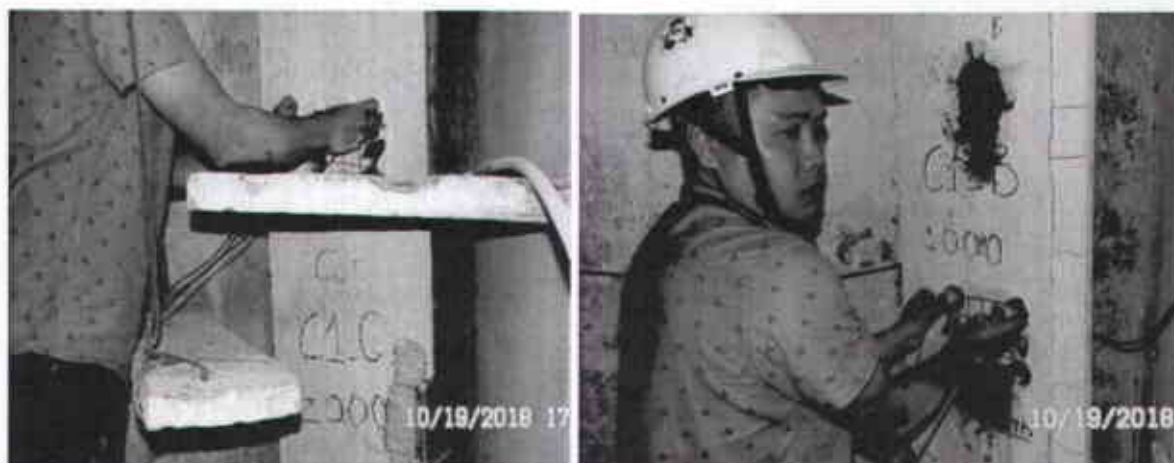
Hình 4.19 - Công tác kiểm tra cường độ bê tông cột dùng thiết bị siêu âm
